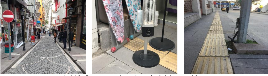
Şekil 5. Yaya aksı üzerindeki engeller (Figure 5. Obstacles on pedestrian road)
