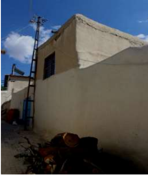
Foto 2f. Kuzeybatı cephe (Photo 2f. Northwest front)
