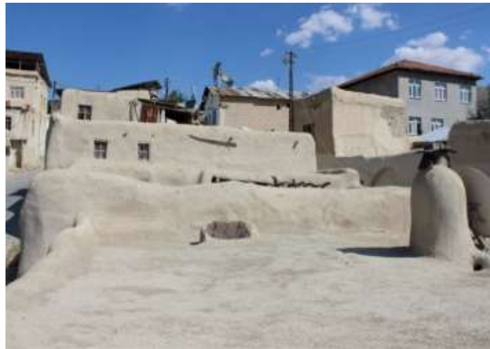
Foto 3ı. Toprak dam (Photo 3ı. Soil roof)
