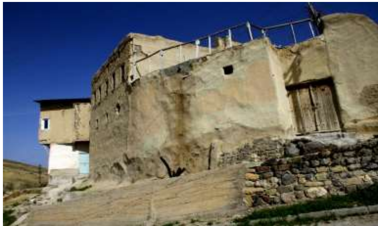
Foto 1c. Güneydoğu cephe (Photo 1c. Southeast front)
