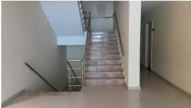
Fotoğraf 24. Kat merdivenleri (Image 24. Floor stairs)
