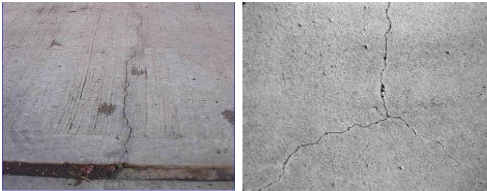
Resim 4. Kuruma-hidrolik-ekolojik rötreye örneği [83] (Photo 4. Example of drying (hydraulic-ecological) shrinkage)
