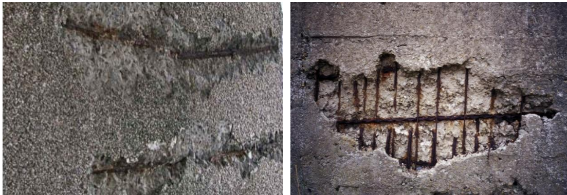
Resim 3. Karbonatlaşma-kimyasal rötre örneği [81] (Photo 3. Example of carbonation-chemical shrinkage)
