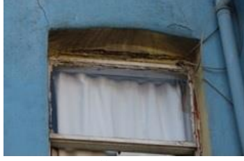
Şekil 11. Pencerenin üst başlığında meydana gelen yüzey kirliliği (Figure 11. Surface pollution in the head of the window)
