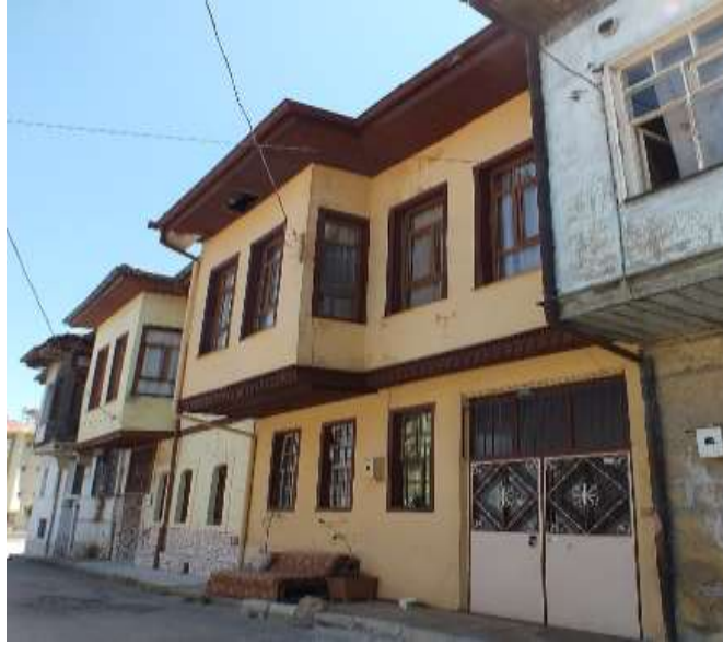
Şekil 11. Kuzey-Giriş cephesi (Figure 11. North-Entrance front)
