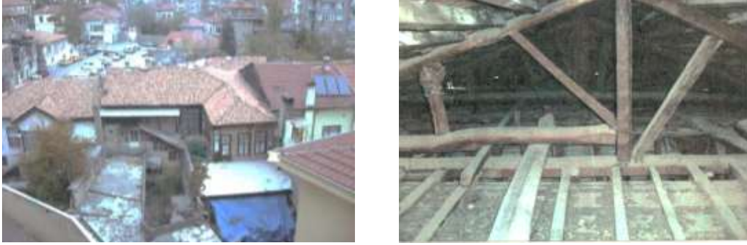
Şekil 10. Çatı strüktürü (Figure 10. Roof and it's structure)
