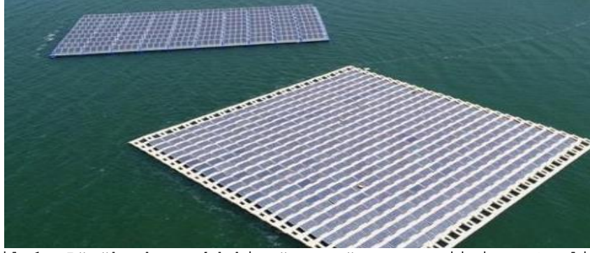
Şekil 1. Büyükçekmece'deki yüzer güneş enerjisi santrali [1] (Figure 1. Floating solar power plant in Büyükçekmece in Türkiye [1])
