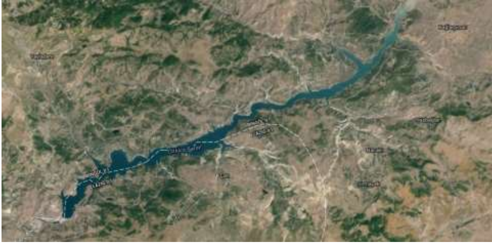
Şekil 2. Özlüce Baraj Gölü'nün genel görünümü [37] (Figure 2. General view of Özlüce Dam Lake)
