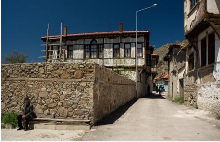
Resim 4. Sivrihisar'da restore edilen konutlar ve mahalle dokusu [2] (Figure 4. Sivrihisar restored homes and texture of the neighborhood [2])
