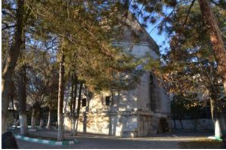
Resim 12. Alemşah Kümbeti [2] (Figure 12. Vault of Alemşah [2])
