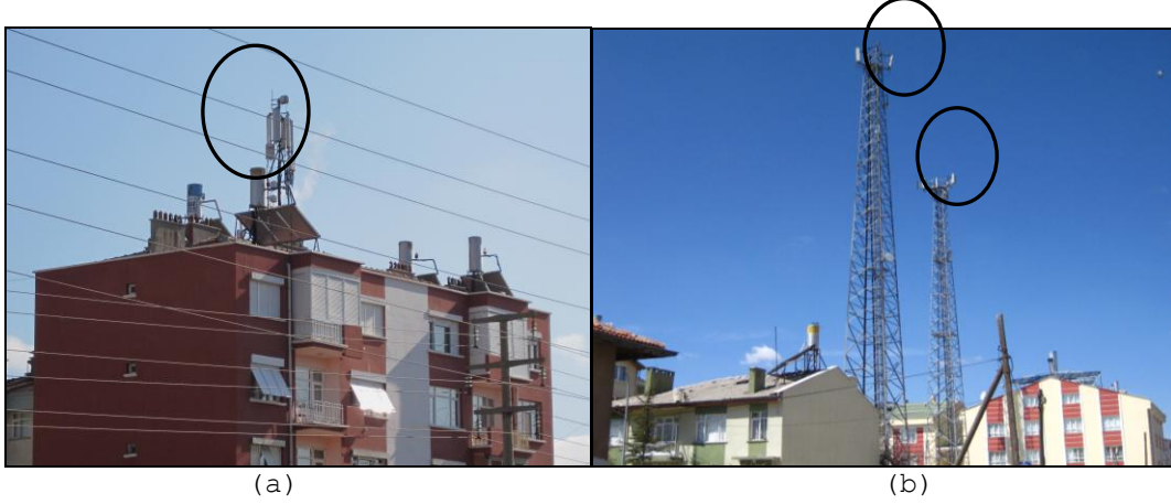
Şekil 3. Yerleşim alanlarına yakın mesafede baz istasyonu (Korkmaz Arşivinden)
