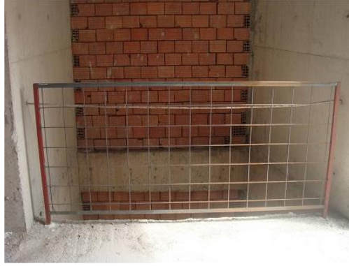
Şekil 2. Asansör boşluğu (Figure 2. Hoistway rail application)
