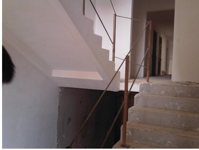
Şekil 1. Korkuluk uygulaması (Figure 1. Stair rail application)
