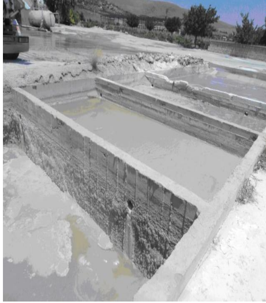
Şekil 3 ve Şekil 4. Süha hazır beton tesisinde yer alan geri dönüşüm havuzu (Figure 3 and Figure 4. Recycle pool in Suha ready-mixed concrete plant)
