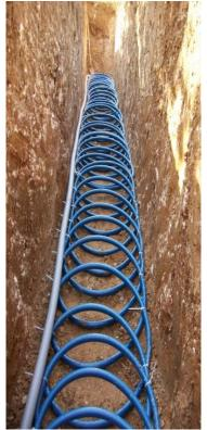
Figure 1. The view of slinky pipes [16] (Şekil 1. Slinky boruların görünümü [16])
