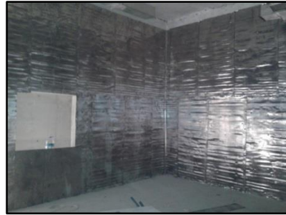
Resim 1. Kurşun plaka üretimi ve kalkanlı zırhlama uygulama örneği[65] (Picture 1. Lead plate production and shielded armor application example)
